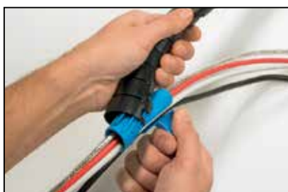
2. Inserte la herramienta de aplicación dentro del Helawrap.
