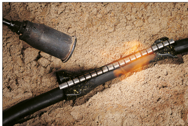
Manșoane de înfășurat RMS pentru repararea rapidă și sigură a cablului pe șantier.
