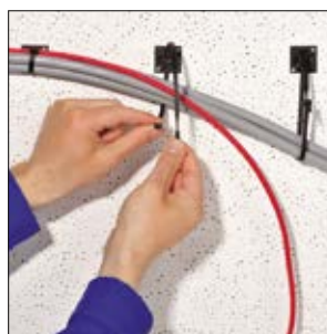
1. Introduceți partea subțire a colierului de cabluri în capătul de blocare deschis.
