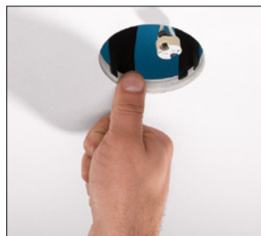
Zatlačením přídržných hrotů do sádkartonu zabráníte následnému posunutí.
