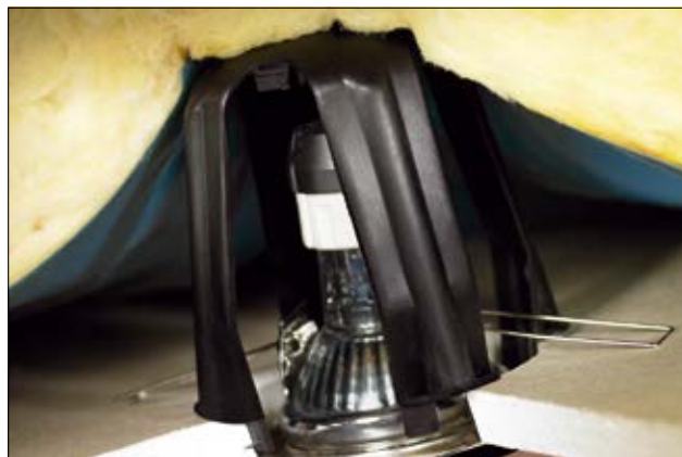
SpotClip-I zaručuje spolehlivost a bezpečnost světelných instalací.
