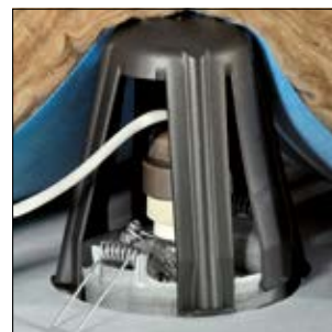
SpotClip-II se standardní izolační vatou.
