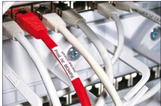
Samolaminovací etikety nabízejí vynikající ochranu potisku proti otěru a vlivu prostředí.
