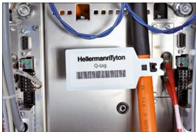
Orientace Q-tagů jako vlaječek zajišťuje snadnou viditelnost tištěného textu.
