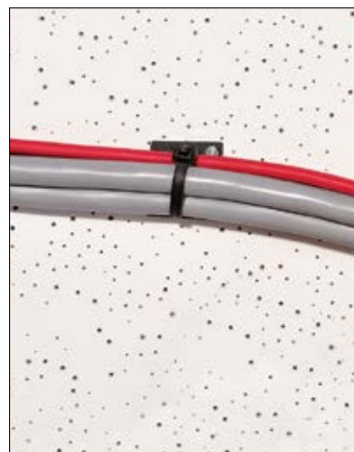
3. Po ukončení instalace lze Q-pásek utáhnout a uštípnout buď ručně nebo utahovací pistolí.
