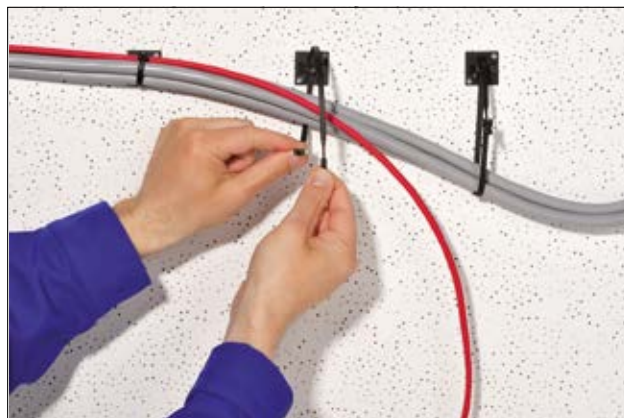
Pouze pásy Q-ties mohou být bez dodatečné námahy použity pro dočasné i finální svázání kabelů.
