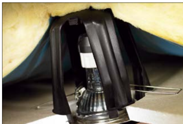
SpotClip-I poskrbi za zanesljivost in varnost inštalacij za razsvetljavo.
