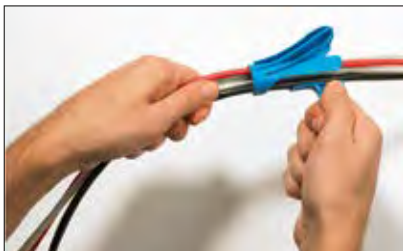
Kabelbündel seitlich in das Aufziehwerkzeug legen.
