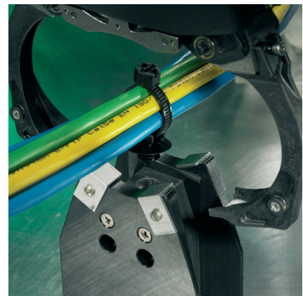
.....电缆束全完束扎完毕，包括支脚。
