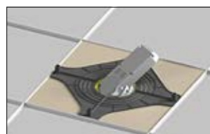
3. Einsetzen des Einbaustrahlers durch die zugeschnittene Montageöffnung.
