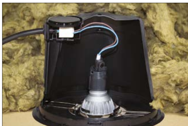
Innenansicht der SpotClip-Box.
