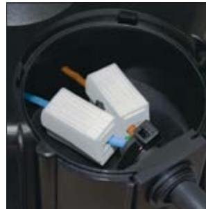
HelaCon Lux verbunden mit der Stromversorgung.
