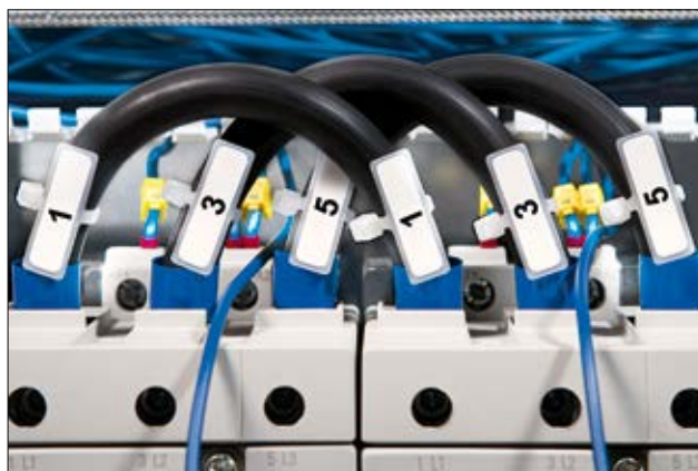
IT Kabelbinder – ein Arbeitsgang mit doppeltem Nutzen.
