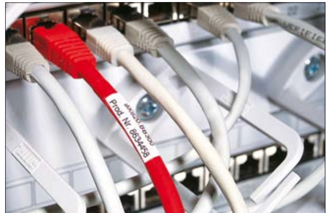
Selbstlaminiierende Helatag Etiketten bieten Schutz gegen Abrieb und Umwelteinflüsse.
