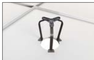
2. Pres piggene ned i pladen for at sikre støtte.
