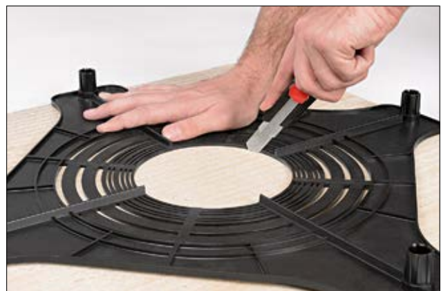
Anvend SpotClip-Plate som skabelon til lofthullet.
