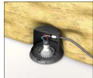
4. Isoleringsmaterialet kan placeres.
