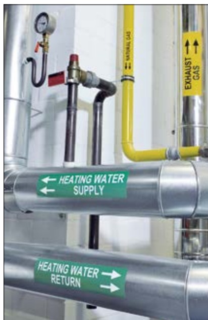
Synlig mærkning af rør.
