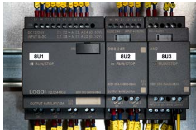
Tydelig opmærkning sikrer nem netværks og cable management.
