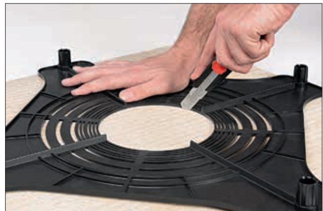
Anvend SpotClip-Plate som skabelon til lofthullet.
