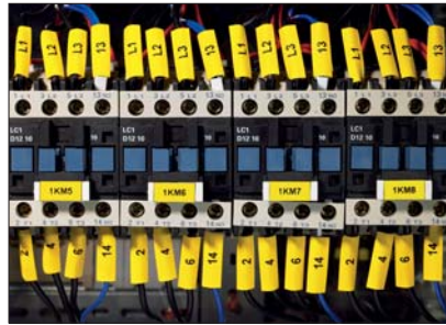
Anwendung des halogenfreien Schlauches im ungeschrumpften Zustand.
