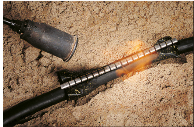
RMS körbefűzhető javítóhüvely a kábelek gyors és biztonságos helyszíni javításához.
