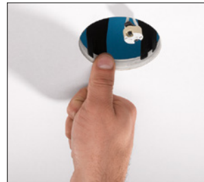
Nyomja a tartótüskéket a gipszkartonba, így megakadályozhatja az utólagos elmozdulást.
