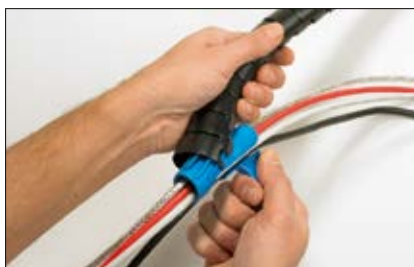
Helyezze a HAT behúzószerszámot a Helawrap kábelburkolat egyik végére.
