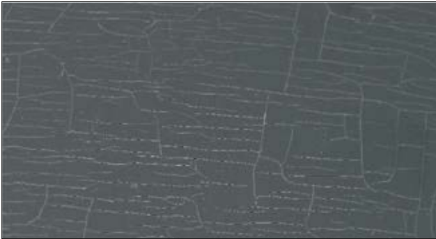
Az ultrabolya sugárzás következtében a csatlakozás károsodott.
