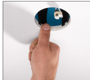
Împingeți știfturile de reținere în panoul gipsat pentru a preveni decalarea ulterioară.
