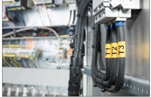
TULT DS - çok çeşitli uygulamalar için iyi mekanik dayanıma sahip daralan işaretleyiciler.
