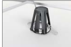
3. Downlight'ın kurulumunu güvenli bir şekilde başlatın.
