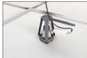
4. Güç kaynağı ünitesini bağlayın ve kabloyu kablo tutucuya sabitleyin.
