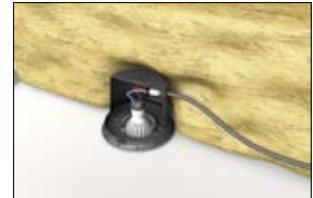
4. Yalıtım malzemesi artık uygulanabilir.
