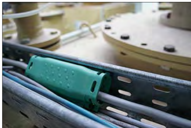
Gel kabelmuffe Relifix V til kabelreparation.
