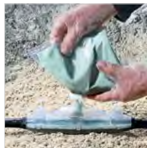
Påfyldningstudsens kombineret med adapteren gør påfyldningen nem og effektiv.
