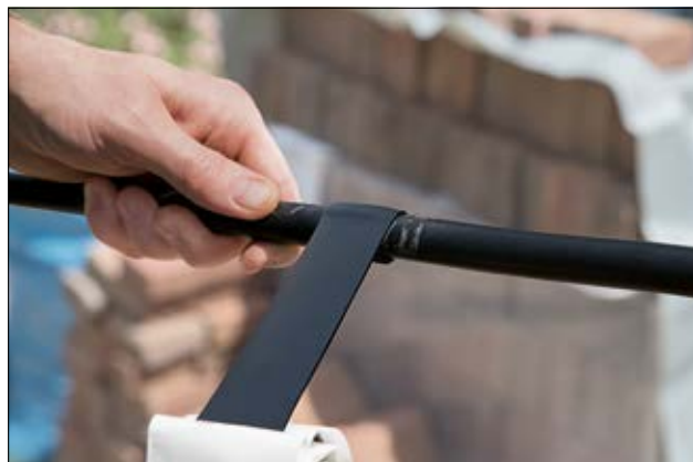
A fita mastic auto-vulcanizante HelaTape Power é altamente flexível.
