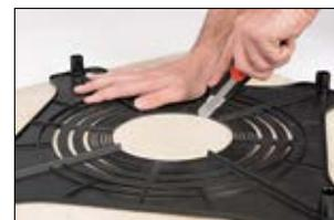
Use o SpotClip-Plate como um stencil para cortar o orifício de fixação na placa do teto.
