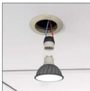
3. Liitä polttimo alasvalon kantaan ja asenna se haluttuun asentoon.
