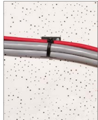
3. Ist die Installation fertiggestellt, wird der Q-tie wie üblich angezogen und abgebunden.
