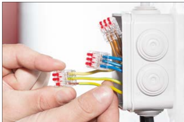
HelaCon öppningsbar toppklämma är enkel att öppna utan verktyg.
