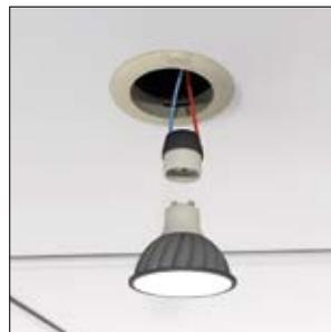
3. Leuchtmittel mit dem Sockel verbinden und in Einbaustrahlergehäuse einsetzen.
