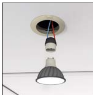
3. Włóż lampę do gniazda i zablokuj ją w prawidłowym położeniu.
