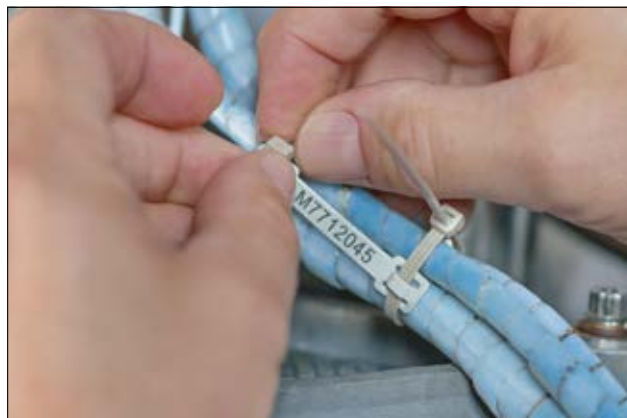
PEEK-materiaalista valmistettu HFTP48 merkintälevy sidotaan PEEK-johdinsiteellä.
