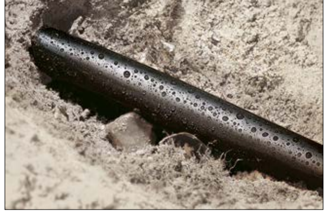
TREDUX HA47 - yeraltı uygulaması.
