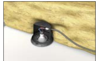
4. Yalıtım malzemesi artık uygulanabilir.
